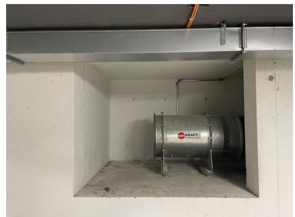
Entrauchungsventilator eingebaut
