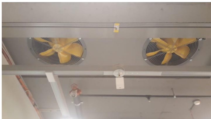
Brandgasventilatoren eingebaut
