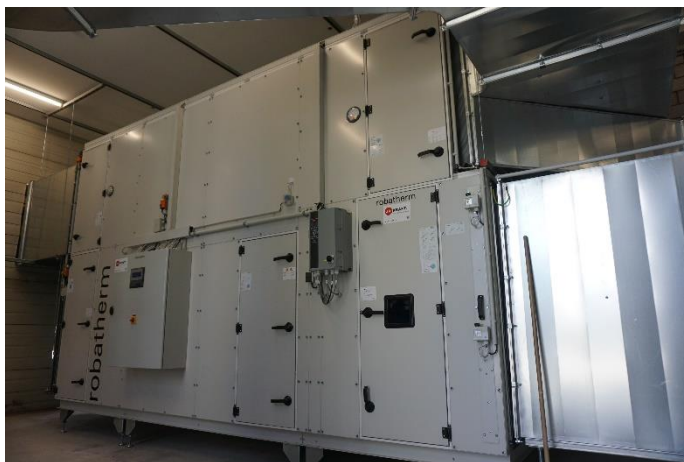
Monobloc gross mit 18'500 m 3 /h, auf Grundrahmen
