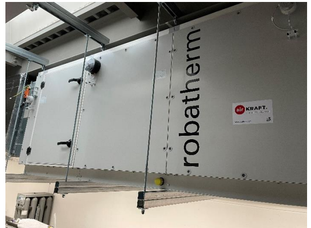
Deckenmontage mit Hilti-Schienen
